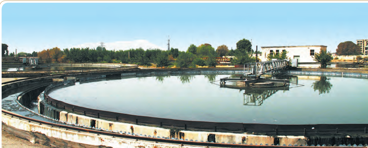
Таҷҳизоти тозакундаи КВД «Обу корези Душанбе».
